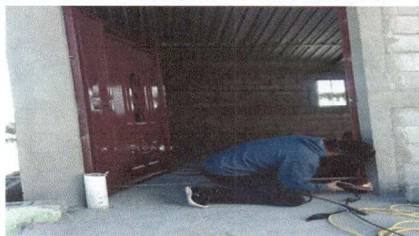
Foto 2: cambio de las laminas y las puertas
