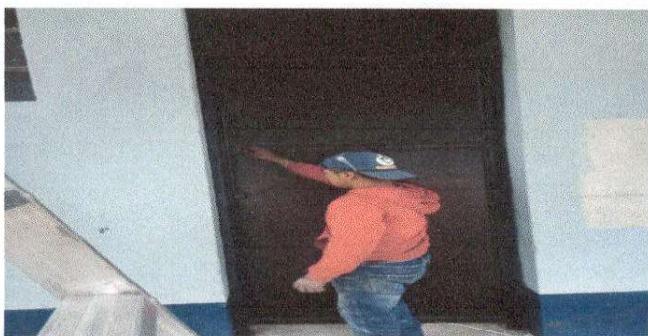
Foto 5: cambio de puerta y las chiapas
