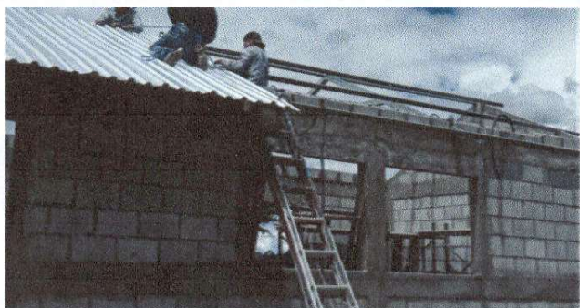
Foto1: el cambio de las laminas y puerta
