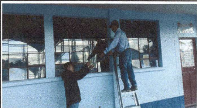
Foto 3: se cambio los vidrios quebrados
